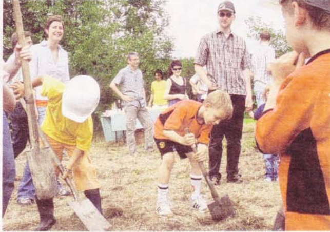
Erste «Aushubarbeiten» für einen Badeteich auf der Baustelle. WPO
