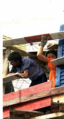
Arbeit auf engstem Raum: Die Kinderbaustelle wird wieder abgebrochen.
